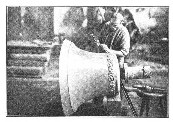
Die fertige Glocke. Das Ornament wird mit Hammer und Meissel sauber herausziseliert, das übrige mit Sandstrahlgebläse gereinigt.
