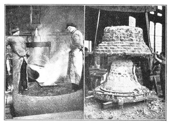
Guss einer kleinern Glocke. Das glühend-flüssige Erz strömt in den Hohlraum der Gussform, zwischen Kern und Mantel.
