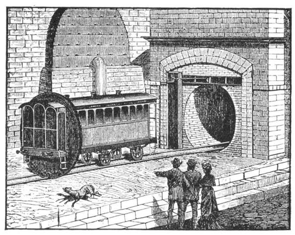
Einfahrt in den Tunnel der "atmosphärischen Eisenbahn", die im Jahr 1865 versuchsweise zwischen London und Sydenham verkehrte. Der Wagen besass hinten eine kreisförmige Scheibe, die genau in die Öffnung des Tunnels passte und diesen luftdicht abschloss.
