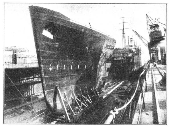
Das neue Vorschiff wird auf einer Gleitbahn mit Hilfe von Flaschenzügen ans Schiff herangezogen, genau ausgerichtet und durch ein kurzes Zwischenstück mit ihm verbunden.
