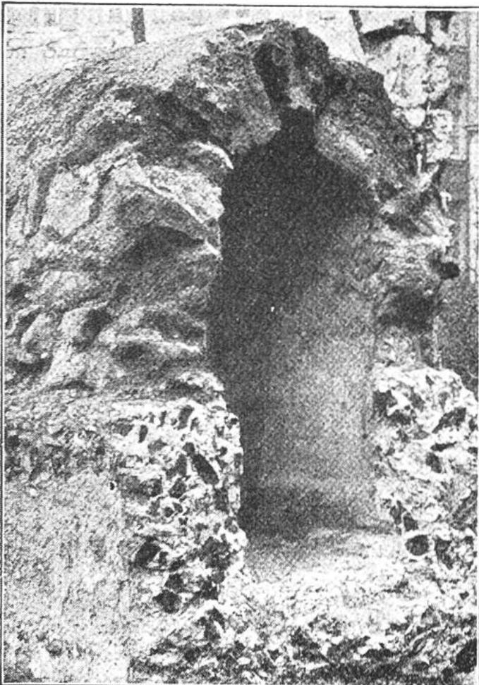
Stück der 90 km langen römischen Wasserleitung, die Köln mit frischem Trinkwasser versorgte. Sie ist etwa im Jahre 80 nach Christus aus Beton erbaut worden.
