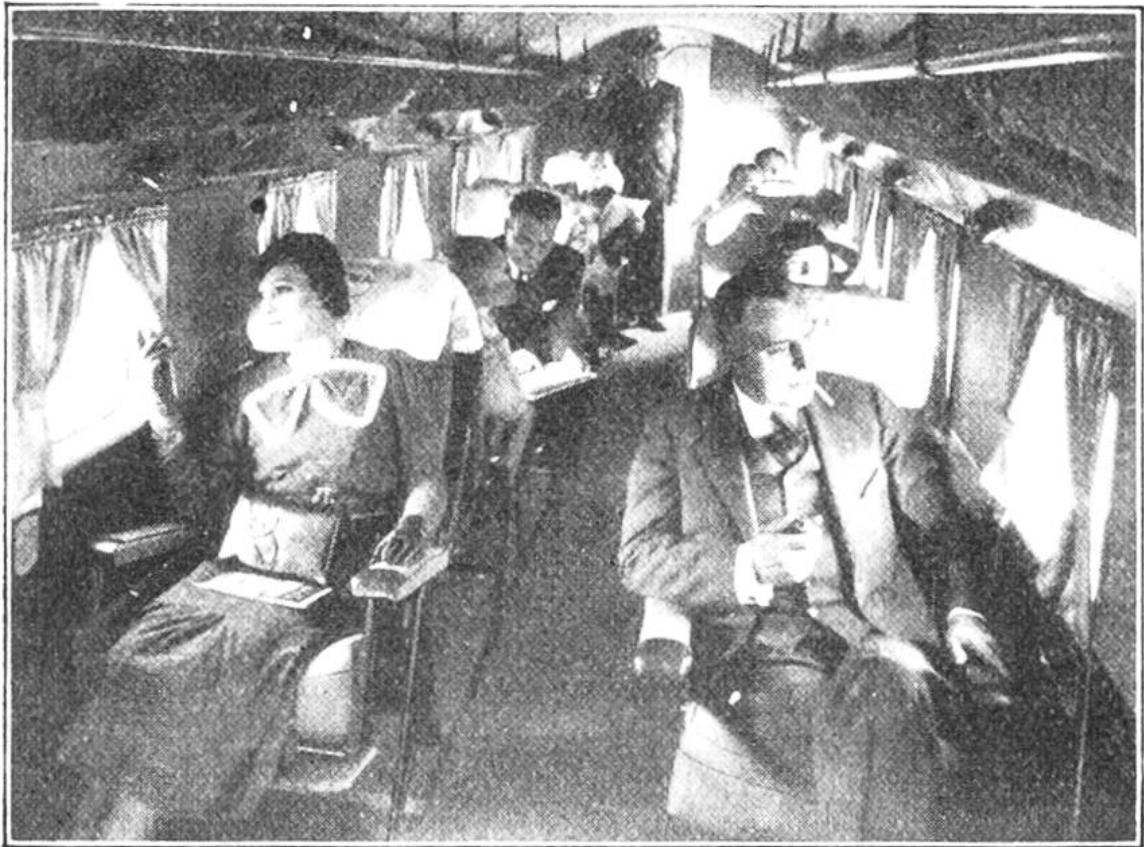
Bequeme Fahrt in einem grossen, modernen Verkehrsflugzeug. Die Passagiere geniessen die herrliche Aussicht oder unterhalten sich wie im Eisenbahnwagen. Der Raum ist so schalldicht isoliert, dass man von einem Ende zum andern in gewöhnlicher Lautstärke sprechen kann. Die Erschütterung ist sehr gering infolge der Gummimontierung der Maschinen.
