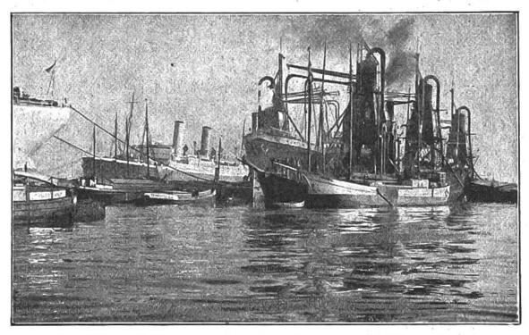
Getreide wird aus den Frachtdampfern mittels Saugrohren verladen. Bild aus dem Hamburger Hafen.
