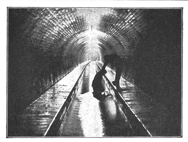
Einer der Hauptkanäle der Abwasseranlage in Berlin. 10-20 m unter der Stadt sind täglich Hunderte von Arbeitern mit der Reinigung der Kanäle beschäftigt.
