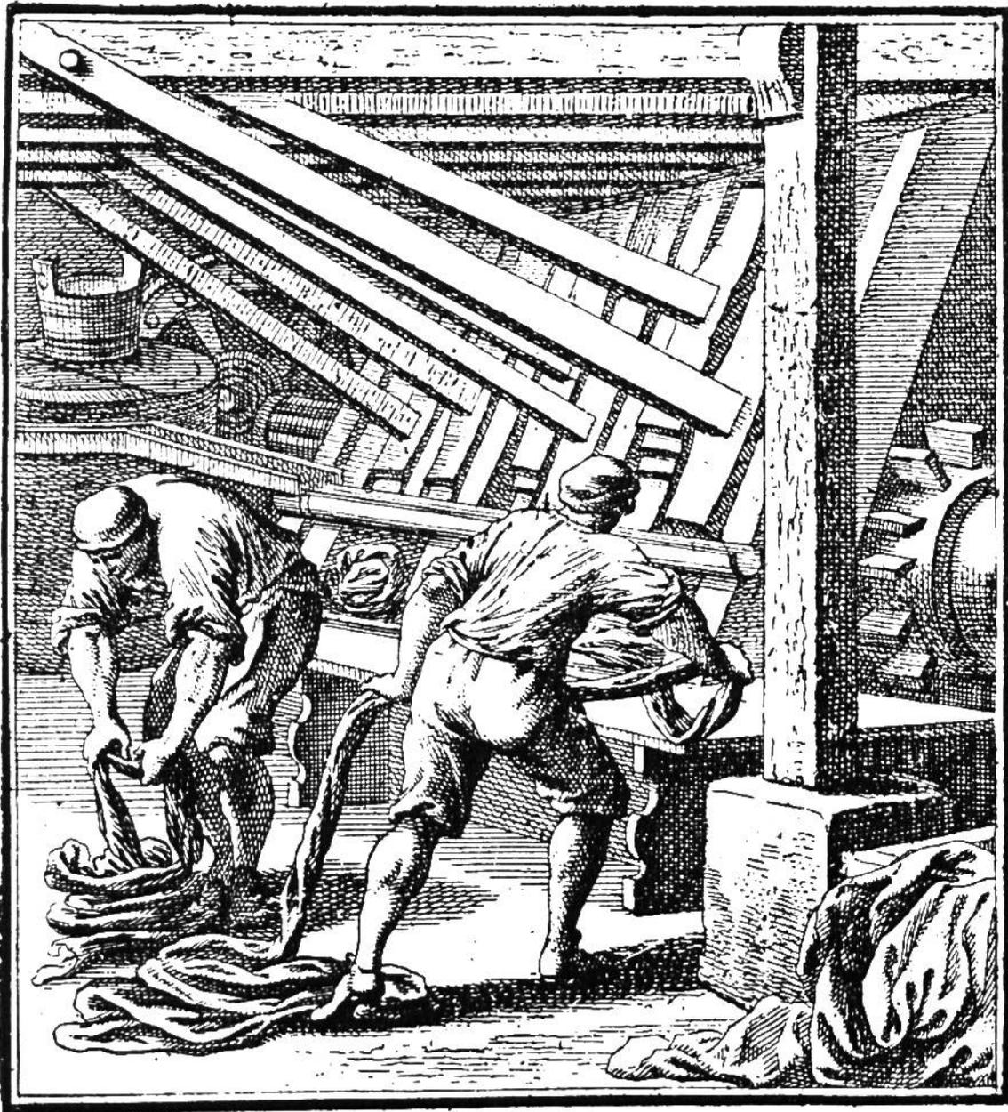
**T u c h - W a l k e n.** Gewobene Wollstoffe werden gewalkt, damit die Stoffasern sich verfilzen. Zu diesem Zweck wurden im Altertum die Stoffe in einer Lauge mit Füßen getreten und schliesslich mit Stöcken geschlagen, mit Disteln rau gemacht und geschoren. Unser Bild zeigt ein Walkwerk mit Hämmern, das ein Wasserrad betreibt. Heute werden zum Walken die Stoffe, zu Strangenform gewunden, zwischen zwei Walzen hindurchgepresst.
