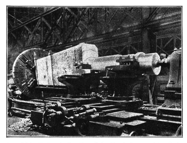
Der gleiche Ruderschaft während der Bearbeitung auf der Drehbank, wobei alles überflüssige Material durch die spanabhebenden Schmiedwerkzeuge beseitigt wird, bis das Stück die rechte Form hat.
