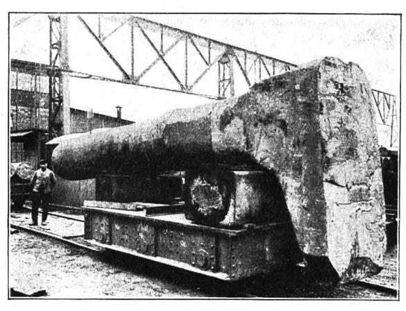
Geschmiedeter, noch unbearbeiteter Ruderschaft, für den (ehemals deutschen) Dampfer, Leviathan" bestimmt. An der Querfläche ist noch der eigentliche Ruderpfosten mit dem Blatt anzubringen. Der dünnere Teil wird mit dem Getriebe der Schiffssteuermaschine verbunden.
