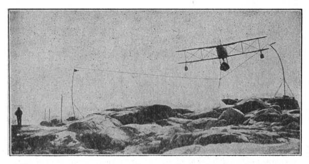
Rettung aus Seenot. Das Flugzeug fasst mit einem Greifer das Ende einer Rettungsleine, die zwischen zwei Stangen gespannt ist, um die Leine auf ein gestrandetes Schiff zu bringen.
