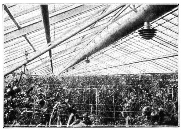
"Wetterfertiger"-Anlage in einem Treibhaus für Tomaten. Die Aussen-Luft wird auf den geeigneten Wärmegrad und Feuchtigkeitsgehalt gebracht und dann durch Anemostate (Windstiller) im Raum verteilt.
