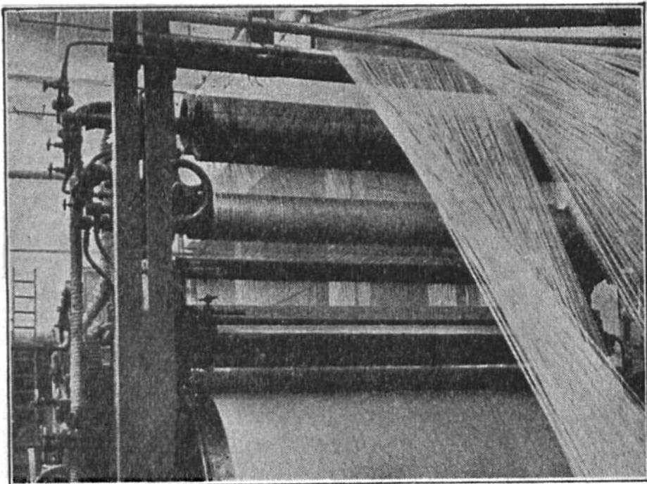
Teilansicht der Maschine, die das „Cordgewebe“ herstellt. Zahlreiche Fäden laufen nebeneinander über Walzen und werden dort gummiiert. Der verbindende Gummi ersetzt den beim Kreuzgewebe notwendigen Schussfaden.
