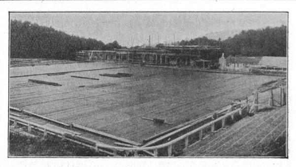
Das Röhrenfeld vor der Einsandung. Auf dem ganzen künftigen Eisfeld liegt Röhre an Röhre; in ihnen fliesst das auf 12 Grad unter Null abgekühlte Salzwasser; auf die Röhren wird Sand ausgebreitet und, wenn dieser gefroren ist, Wasser darüber geschüttet, das bald zu Eis erstarrt.
