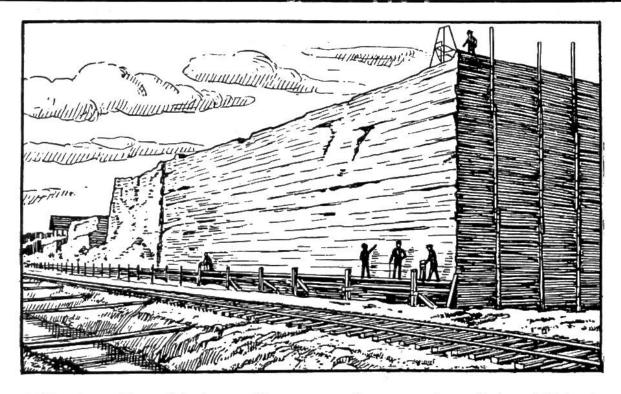
Mit der Frasch'schen Pumpe aufgepumpter Schwefelblock von 100000 Tonnen. Der mit der Pumpe geförderte goldgelbe Schwefel läuft in hohe Bretterverschläge und erstarrt rasch schichtweise, worauf die Verschläge entfernt werden.
