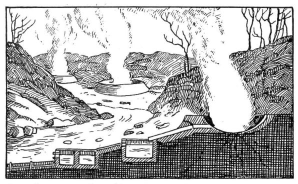
Gewinnung der Borsäure in der Toscana. Der Dampf wird in grosse, mit Wasser gefüllte Becken geleitet, wo er sich verdichtet und die Borsäure an das Wasser abgibt. Die Borsäurelösung wird unter Ausnutzung der heissen Dämpfe so lange eingedampft, bis die Borsäure auskristallisiert.
