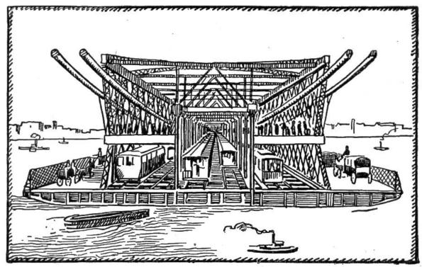
Querschnitt durch die Williamsburg-Hängebrücke über den East-River in New York. Auf jeder Seite oben zwei Trag-Kabel. Die 36 m breite Brücke ist eingeteilt in (von links nach rechts): Fahrdamm für Fuhrwerke (heute Autos), Strassenbahn, Hochbahn, Strassenbahn, Fahrdamm; über der Strassenbahn beidseitig je ein Radfahr- und ein Fussweg. Die nutzbare Breite beträgt 50 m.
