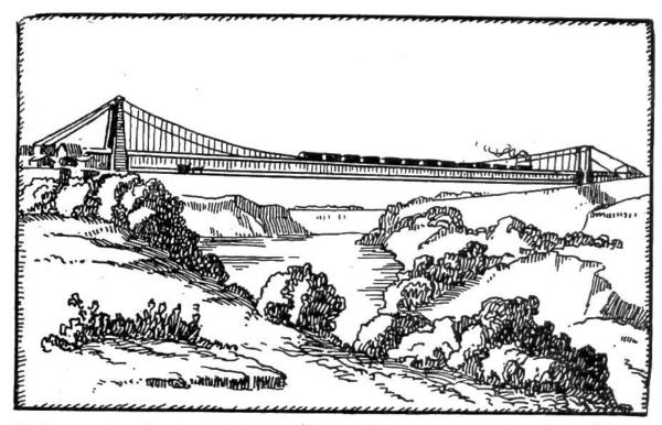
Hängebrücke über den Niagara, in den Jahren 1851—55 erbaut. Sie war die erste Hängebrücke, über welche die Züge einer Haupteisenbahn rollten und besass eine Spannweite von 250 Metern. Ein halbes Jahrhundert diente sie dem Verkehr.
