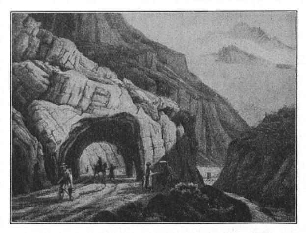
Das Urnerloch. Der Verkehr über den St. Gotthard wurde im Mittelalter erst dadurch eröffnet, dass man die Schöllenenschlucht passierbar machte. Das geschah durch eine mit Ketten an die Felsen gehängte Holzbrücke, den "stiebenden Steg". 1839 wurde der Steg durch einen Tunnel ersetzt. (Nach einer Zeichnung von Anton Winterlin, um 1850.)
