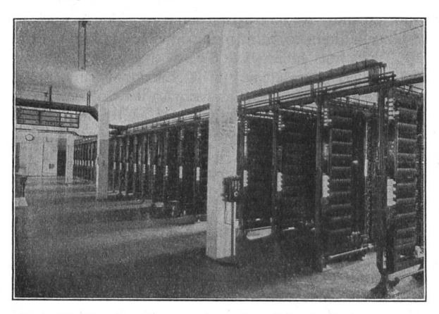
Automatische Zentrale, ohne jede Bedienung durch menschliche Hand. (Einrichtung für 6000 Teilnehmer, mit einem Verkehr von täglich 24000 Verbindungen, welche Arbeit sonst 15 bis 18 Telephonistinnen verrichten müssten.)
