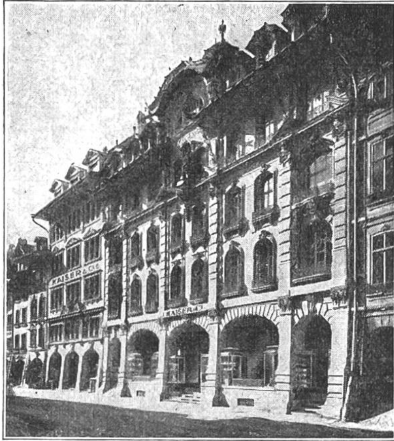
Teilansicht der Geschäftshäuser Kaiser & Co. A.=G.
