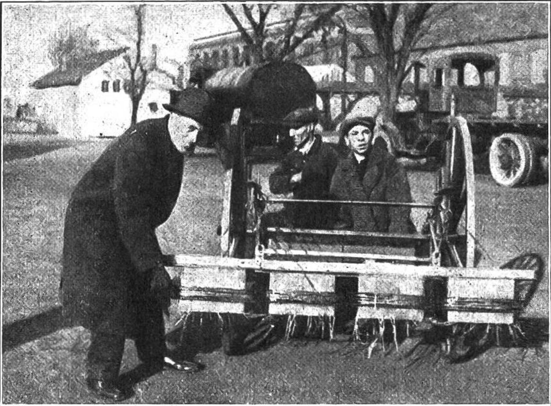
Ein origineller Straßenreiniger, der die Verkehrswege von Nägeln und allerlei Eisenteilen befreit. Der Wagen, ein kleiner Anhänger, ist von einer Fahrt heimgekehrt und mit zahlreichen Nägeln behaftet. — Die Vorrichtung ist einfach: der Elektromagnet ist ein mit elektrischem Leitungsdraht umspultes Eisen. Bei eingeschaltetem Strom ist das umwickelte Eisenstück magnetisch.
