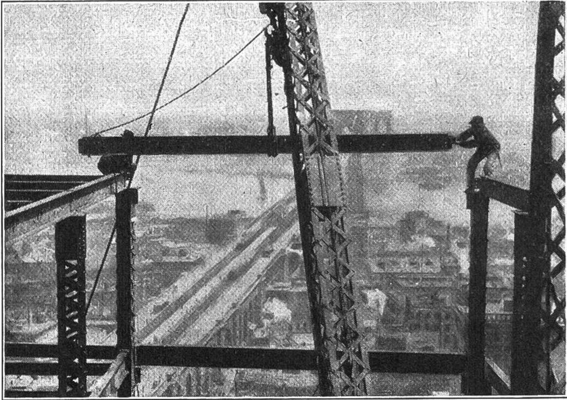
Bau eines Wolkenkräfers. Ein Eisengerippe gibt dem Gebäude Halt. Der Riesenarm eines Krans trägt die Eisenbalken an die gewünschte Stelle.
