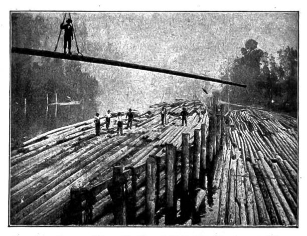
Bau eines Zigarrenfloßes. Ein Kran hebt die 30-55 m langen Stämme so leicht, als ob es Zündhölzer wären, und ordnet sie rasch und sicher.
