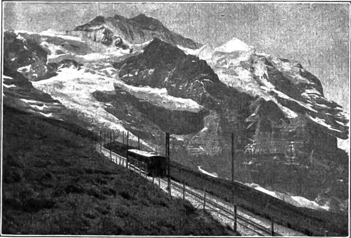
Die elektrisch betriebene Jungfraubahn, ein gewaltiges Werk moderner Bahnbaukunst im Hochgebirge.
