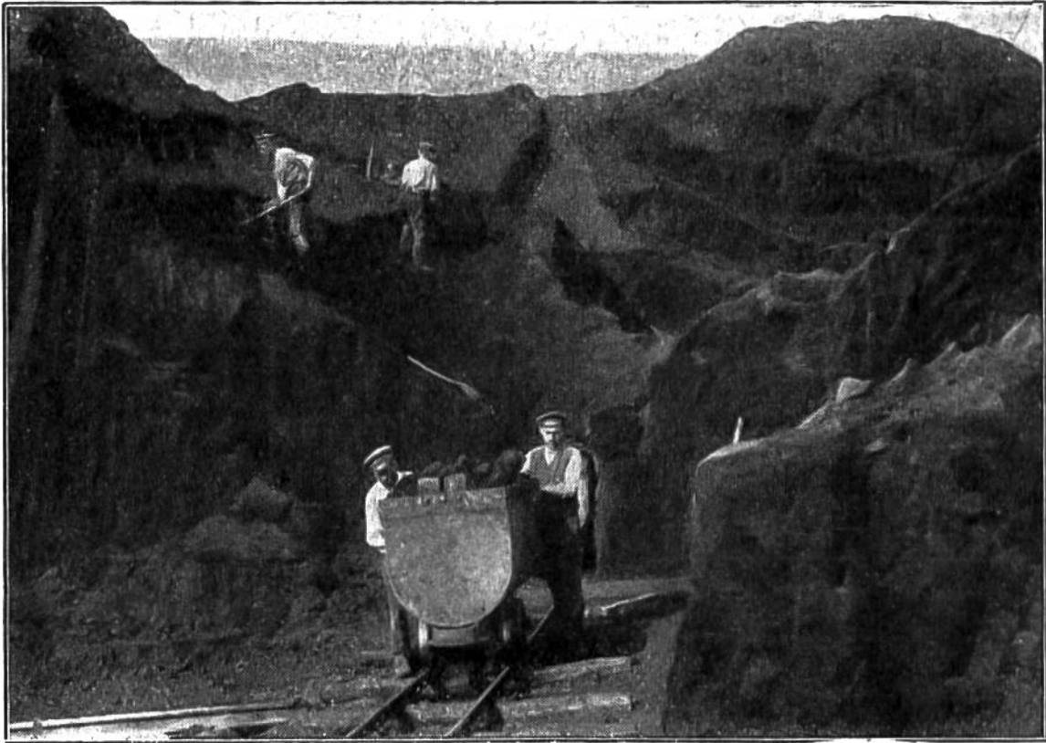
Braunkohlen-Tagebau. Die mit Spitzhaden losgehauene Kohle rollt in Wagen herunter und gelangt darin nach der Brikettfabrik.
