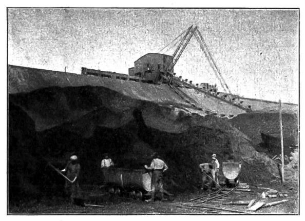
Die über der Kohlenschicht liegende Erddecke wird weggebaggert und das Material an ausgebeuteten Stellen wieder aufgeschüttet.
