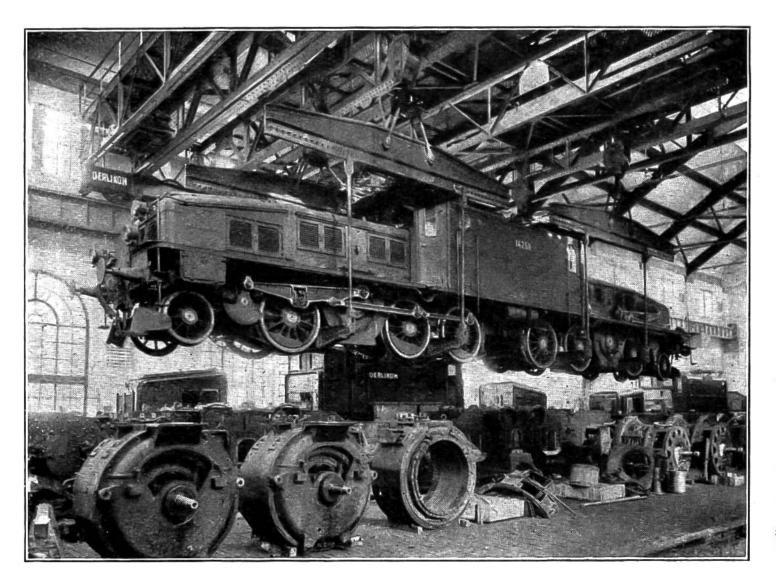
Reparat ur wert stätte der schweizer. Bundessbahnen in Bellinzona. Zwei von der Maschinensastit Gerlikon gelieferte Caststräne heben mit vereinten Kräften eine der mächtigen auf der Gotthardstrecke verwendeten Güterzugslokomotiven. Ihr Gewicht besträgt 105 000 kg. Jeder Kran vermag 80 000 kg zu heben. Dank eines sicheren Steuersystems können sie kleinste und größte Gewichte sicher und genau handhaben.
