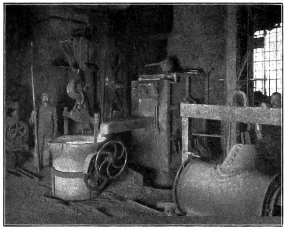
Aus Stätten schweizerischer Arbeit. Ein Schmelzofen in der Maschinenfabrik von Theodor Bell & Cie. A.=G., Kriens. Das Bild zeigt das "Abstechen" des flüssigen Eisens aus dem Schmelzofen und Süllen eines 3,5 Tonnen fassenden Gießkessels.
