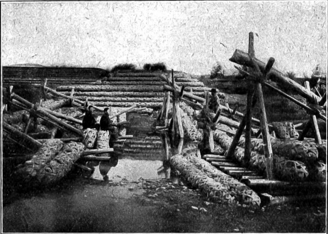
Bei der Bewässerung von Reisfeldern in Japan werden zum Abdämmen der Wasserrinnen mit Steinen gefüllte Bambusneße verwendet.
