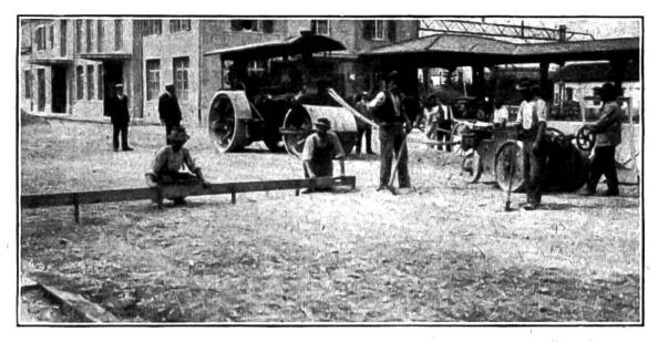
Straßenbau: Die von der Walze gezogene kleine Maschine reißt das Straßenbett auf; der Kies wird gegen die Mitte zu erhöht aufgetragen, damit das Regenwasser besser abfließt. Die schwere Dampfwalze preßt und ebnet den Grund.
