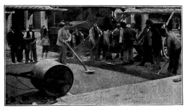
Auf die geebnete und mit geteertem Schotter bedecte Unterlage wird das Asphaltpulver aufgetragen, dann mit erhitzten Walzen, Stößeln und "Bügeleisen" zusammens gepreßt und zu einer beim Erkalten festen Masse geplättet.
