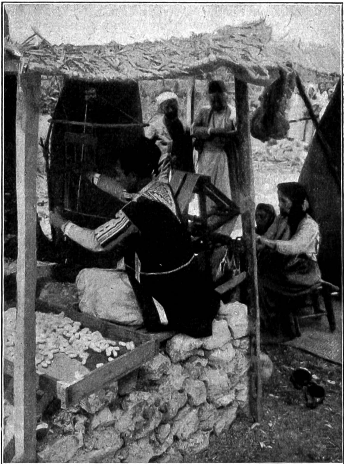
Seidenindustrie im nördlichen Syrien (asiat. Türkei). Die Cocons (eingesponnene Seidenraupen) werden gelocht; dadurch löst sich das Fädenende. Der Arbeiter verbindet mehrere der kaum sichtbaren feinen Fäden und befestigt sie am Haspel, der von einer Frau gedreht wird.
