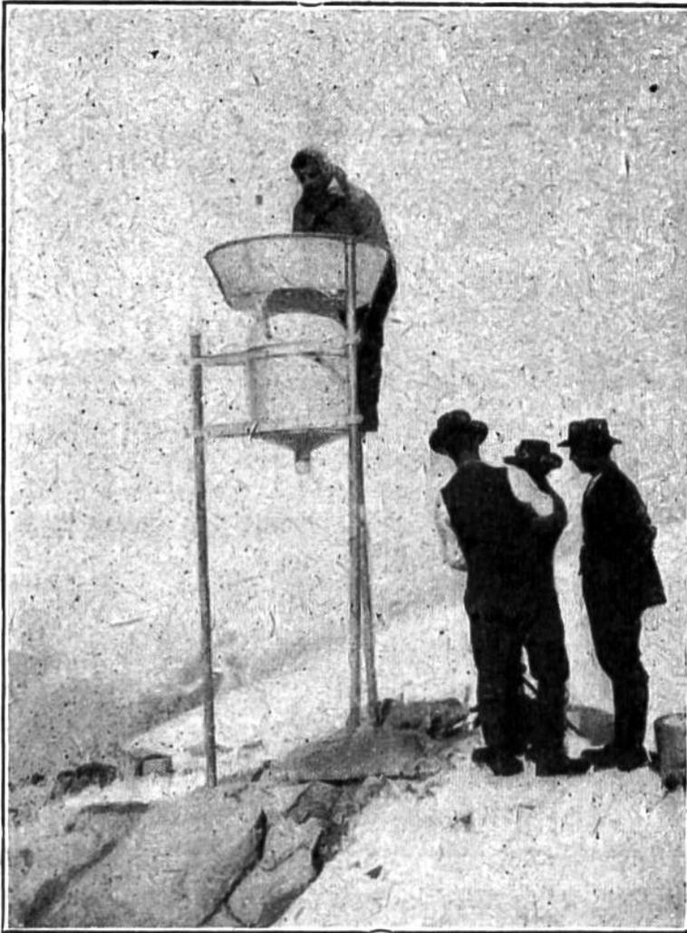
Der Totalisator. Für die Untersuchung der Gletscherbewegungen muß man die Niederschlagsmengen kennen. Schnee und Regen werden in Kesseln aufgefangen, und von Zeit zu Zeit wird ihr Inhalt genau festgestellt.
