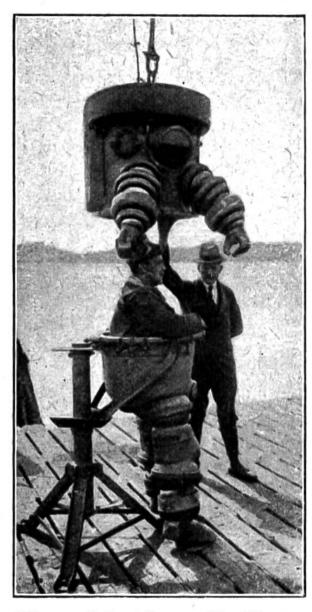
Eiserne Hosenträger. Die schwere Glode mit den Greifhänden wird heruntergelassen und aufgeschraubt.
