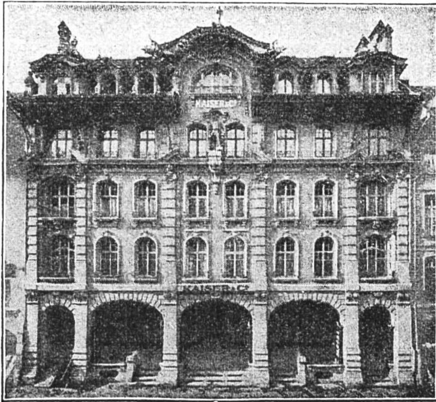
Geschäftshaus Kaiser & Co., Marktgasse 39-43.
