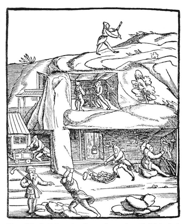
Schematische Darstellung eines Bergwerkes aus dem 16. Jahrhundert. Oben Mann mit der Wünschelrute, in der Mitte "Haspler" an der Welle, unten Schiebekarren auf Holzgeleisen (den ersten Schienen) und "Hauer".
