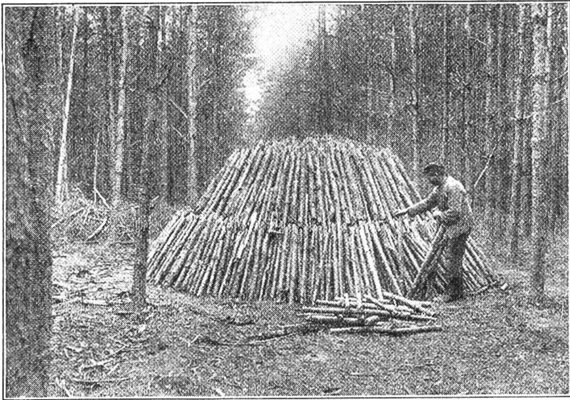
Der Köhler beim Aufschichten des Holzes.
