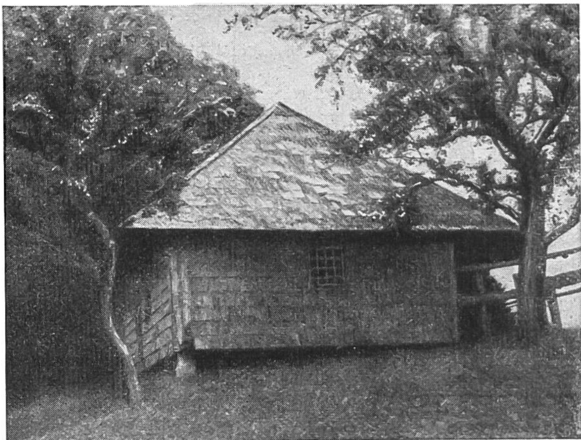
„Hohwachthäuschen“ bei Langnau. In der Südwand befindet sich jetzt noch ein Rohr, das auf den „Chuz“ Balmegg bei Trub eingestellt ist. In den andern Wänden sind nur noch Öffnungen erhalten für die einst auf andere „Chuzen“ eingestellten Rohre.
