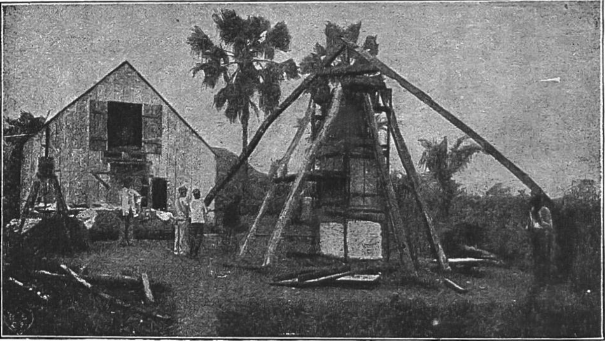
Primitive Baumwollpresse in Kamerun.
