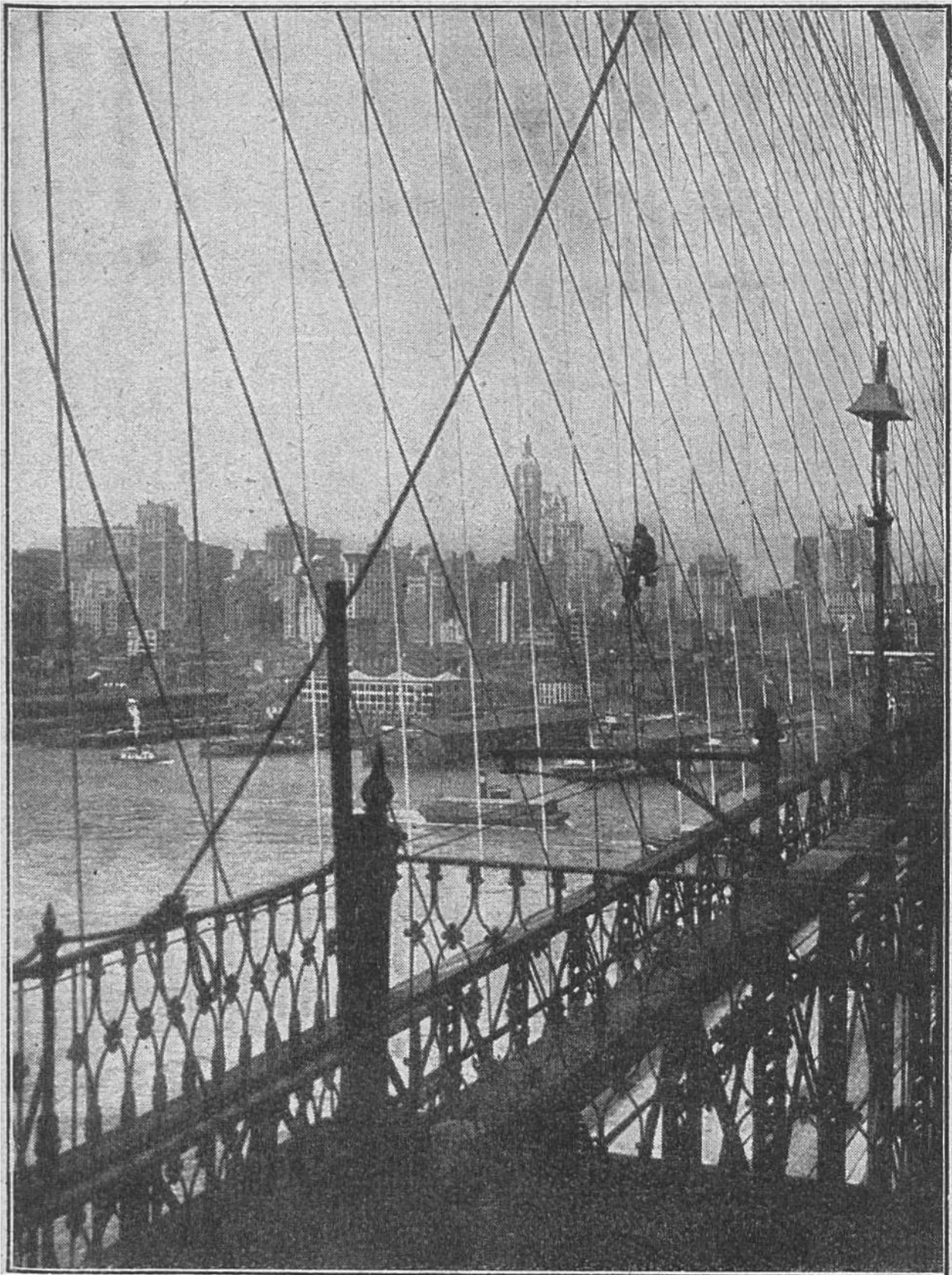
Malerarbeit an der Brooklynbrücke, der größten Hängebrücke der Welt (1800 Meter lang). Hängebrücken verlangen sorgfältige Instandhaltung. Seitdem vor mehreren Jahren, an einem heißen Tage, einige Seile rissen, sind jahraus jahrein Maler beschäftigt, sie neu anzustreichen. Diese Bemalung kostet alljährlich 2\frac{1}{2} Mill. Franken.
