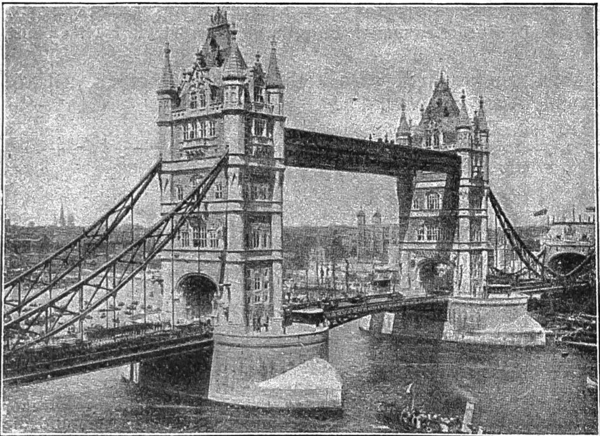
Die Tower-Brücke über die Themse in London, 1886–1894 erbaut für 40 Millionen Franken, 805 m lang. Die Fahrbahn des Mittelstückes kann durch mächtige Maschinen aufgeklappt werden zum Durchlassen grosser Schiffe. Bei Unterbruch ist für Fussgänger die obere Brücke (43 m über Wasser) benutzbar.
