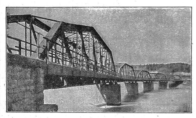
Aarebrücke bei Koblenz, Erbauer Bosshard & Co., Näfels. Beispiel einer Eisenbrücke mit Trägern über der Fahrbahn, ähnlich wie bei einer gedeckten Holzbrücke.
