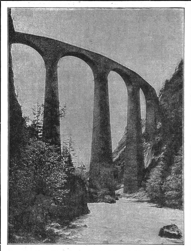
Landwasser-Viadukt der Albula-Bahn bei Filisur (Grbd.). Nach Verlassen eines kurzen Tunnels fährt die Bahn über den 130 m langen und 65 m hohen Viadukt, der aus sechs Bogen mit je 20 m Lichtweite gebildet wird. Die Brücke überrascht durch ihre mächtigen, aber trotzdem schlank erscheinenden Pfeiler und durch die gebogene Form (100 m Radius), die ihr ein ganzeigenartiges Aussehen verleiht. Sie ist ein Musterbeispiel moderner, der Landschaft gut angepasster Technik.
