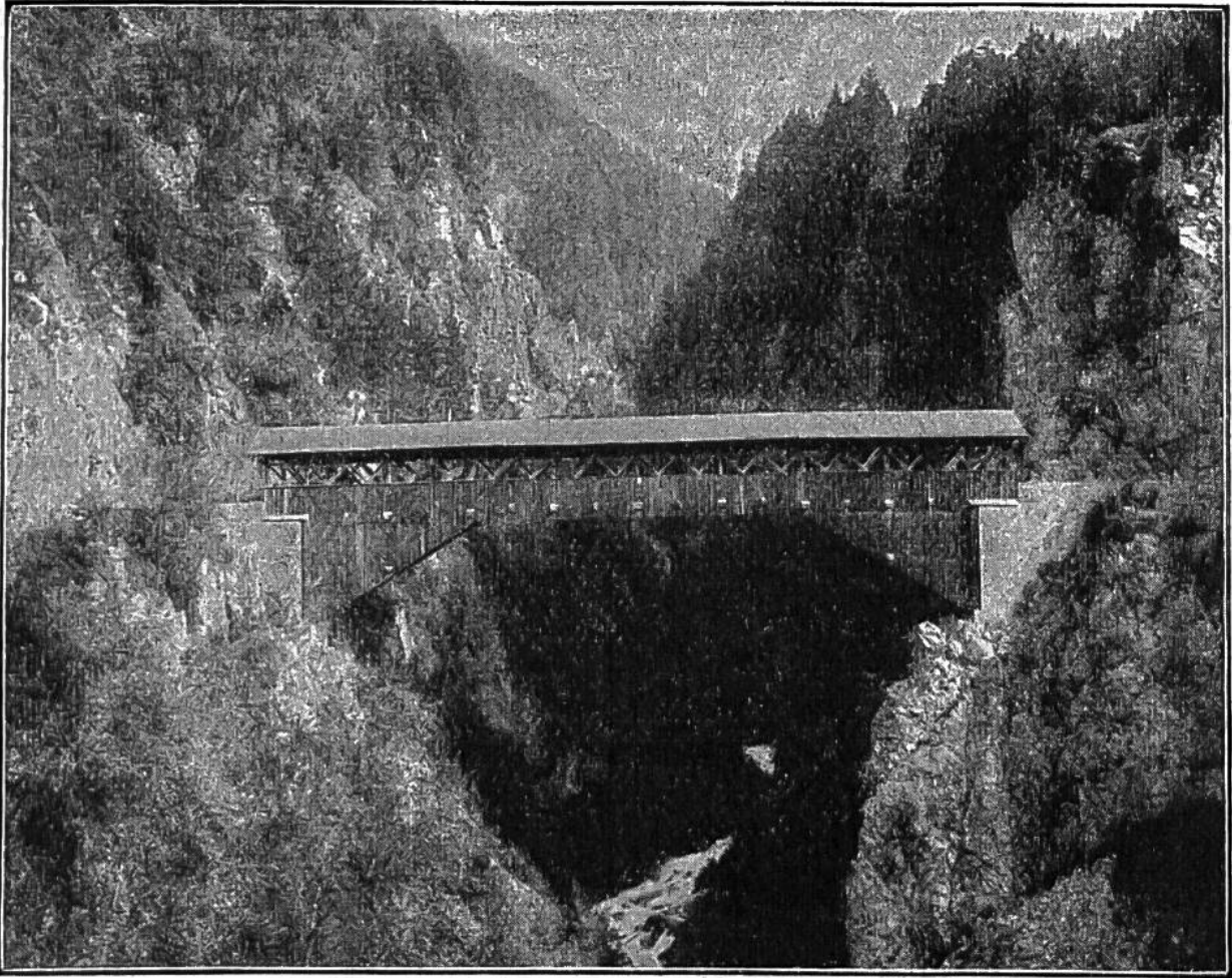
Rusein-Brücke bei Disentis (Graubd.), 56 m lange Holzbrücke, erbaut 1857, 45 m über dem Rusein-Bach.
