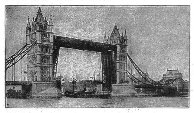
Aufgezogene Tower-Brücke, Schiff bei der Durchfahrt. Im Jahre 1916 passierten 3354 grosse Schiffe; das Heben der in zwei Teilen aufklappbaren Fahrbahn kostet jedesmal ungefähr Fr. 150.—. Die "Tower-Bridge" ist die grossartigste Aufziehbrücke. Anderswo wurden Drehbrücken zur Behebung der gleichen Schwierigkeiterstellt.
