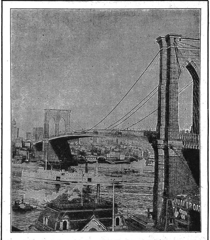
Brooklin-Brücke zwischen New York und Brooklin über den East-River. Die grösste Hängebrücke der Welt, 1850 m lang. Bis zum Bau des deutschen, 47,5 m hohen Riesendampfers "Imperator", konnten auch die grössten Schiffe unter dem 41 m hohen Bogen durchfahren.
