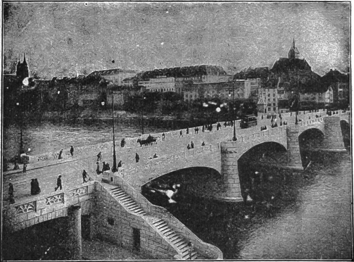
Die neue Rheinbrücke in Basel, aus Granit erbaut 1903–5. An Stelle einer Holzbrücke aus dem XIII. Jahrhundert, 195 m lang und 18 m breit, 6 Bogen. Beispiel einer architektonisch schönen und geräumigen Stadtbrücke.
