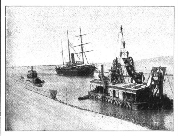
Baggermaschine zum Entsanden des Grundes.
