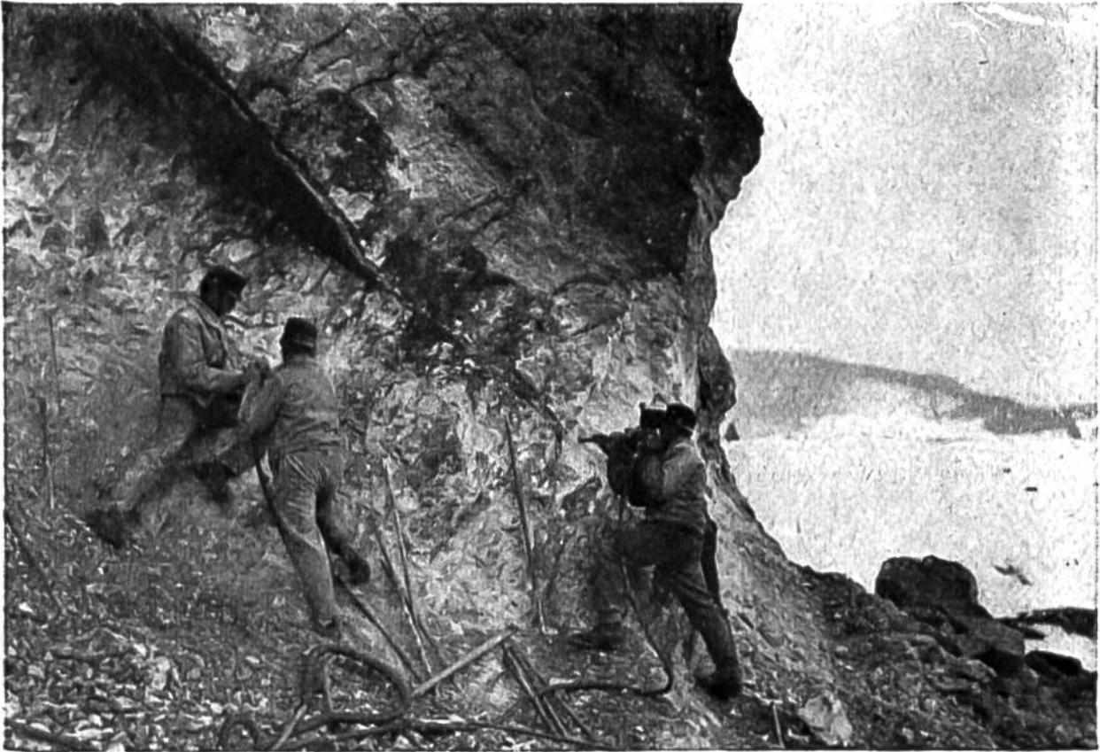
Bohrung von Sprenglöchern mittelst Druckluft durch Sappeure
