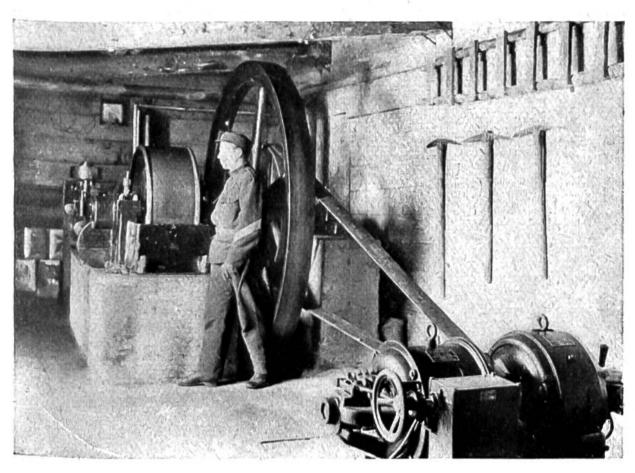
Elektrische Maschinenanlage zum Betriebe des Scheinwerfers.
