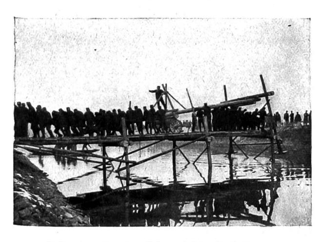
Brückenbau: Bau einer Kolonnenbrücke durch Sappeure.
