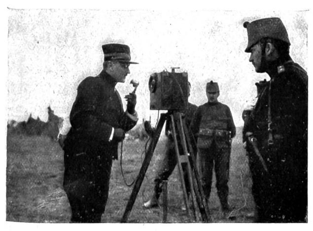
Die telephonische Verbindung mit dem aufgestiegenen Fesselballon.
