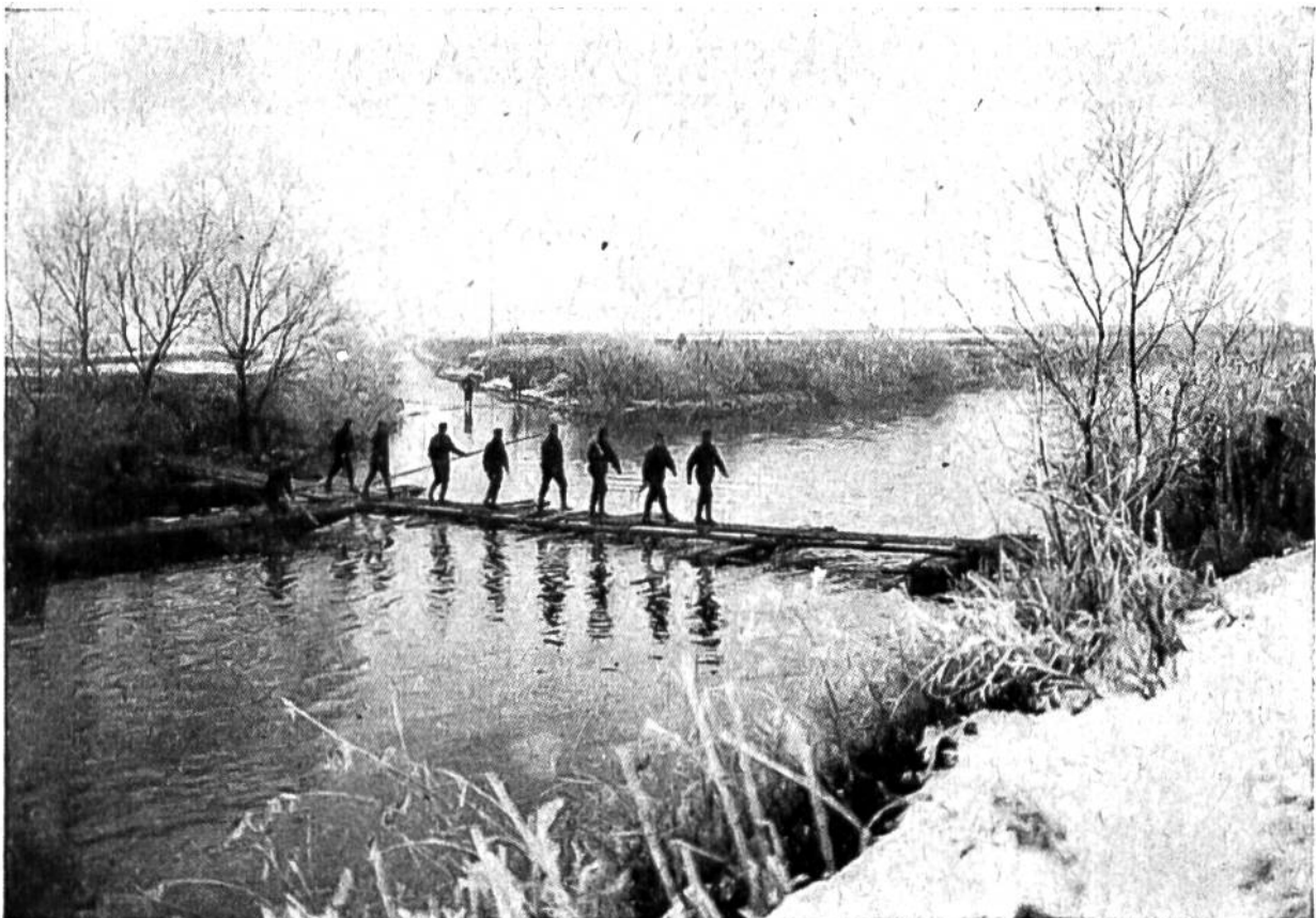
Rasch aufgeschlagener Fussgängersteg.
