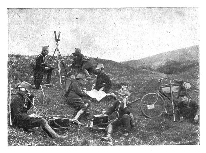
Kommando einer Feldartillerieabteilung. Die Befehle des beobachtenden Kommandanten werden durch das Feldtelephon an die Batterien weitergeleitet.
