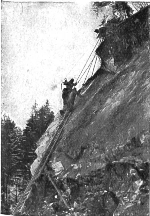
Schwierige Bohrarbeiten. — Strassenbau an der Pierre-Pertuis.
