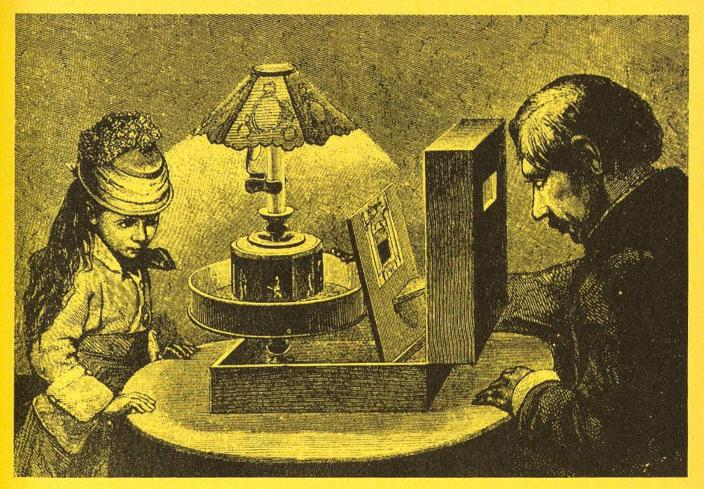
Beim Praxinoskop wurden die Bilder von der Zylinderinnenwand über eine im Zentrum angeordnete Spiegeltrommel nach schräg oben reflektiert. Durch eine Visiereinrichtung, wie rechts dargestellt, betrachtet, schienen sich die Figuren gleichsam auf einer kleinen Bühne zu bewegen.
