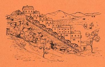
Wasserräder können nur verhältnismässig kleine Fallhöhen — bis etwa 12 Meter — nutzen. Bei grösseren Höhen muss die Nutzung stufenweise, durch hintereinandergebaute Einzelwasserräder, erfolgen. Ein besonders schönes Beispiel dafür war diese gallorömische Mühlengruppe, die im 2./3. Jahrhundert nach Christus in Barbegal bei Arles in Frankreich stand.
