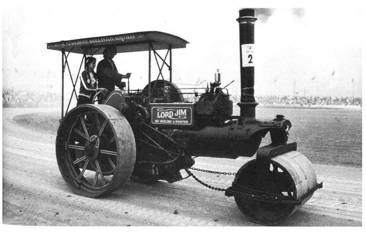
Diese Strassenwalze wird über Ketten gelenkt.
