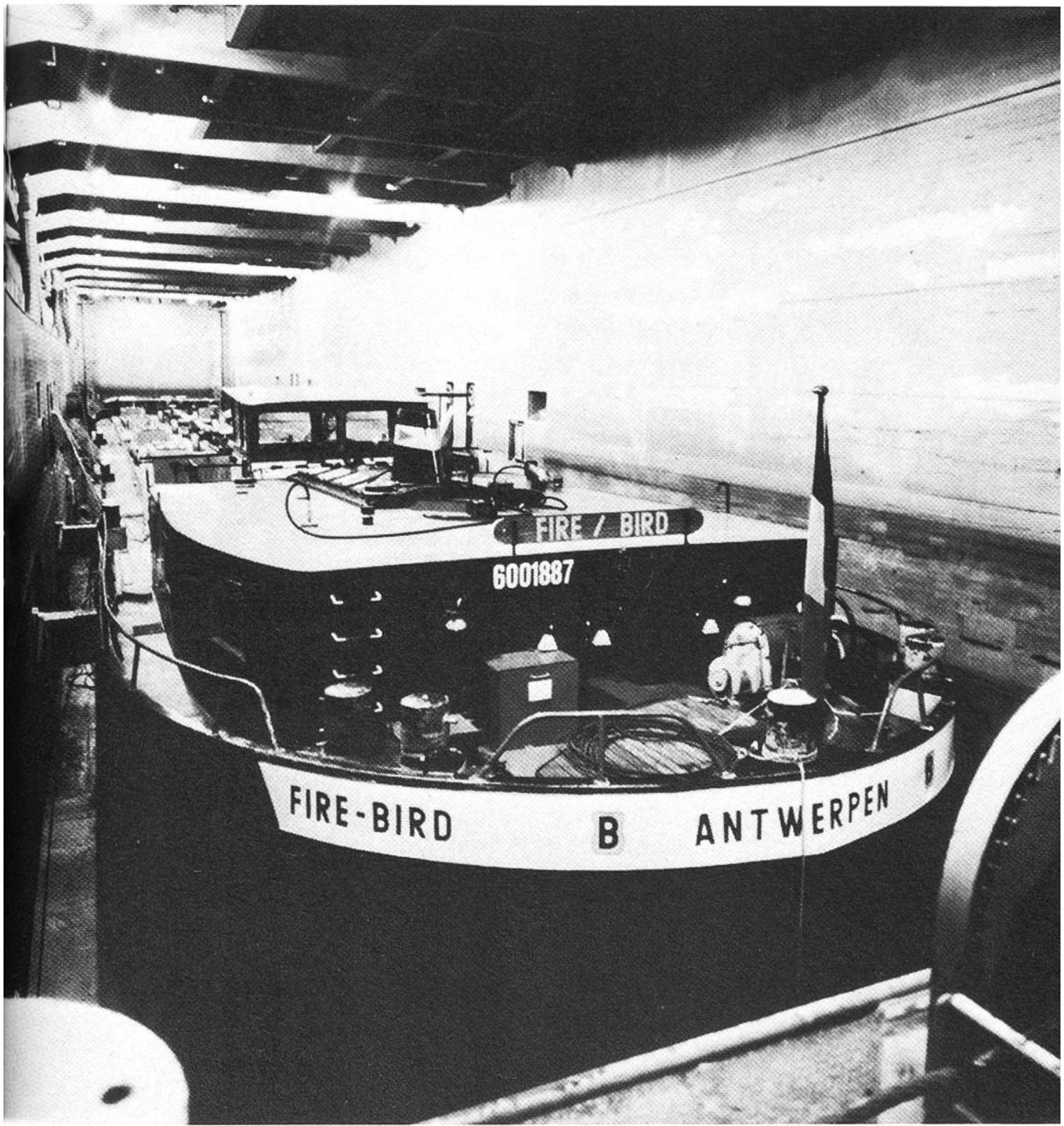
*Im Bauch des «Baco-Liner» werden die eingeschwommenen Schiffe festgemacht und «verankert», so dass auch bei Sturm und hohem Wellengang nichts passieren kann.*
