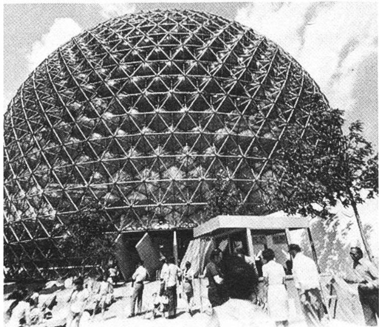
*Sei es das Gerüst einer Kieselalge, seien es Bienenwaben oder ein moderner Kuppelbau: Die Natur hat längst «herausgefunden», dass Bauelemente in Sechseckform besonders stabile Konstruktionen ergeben.*
