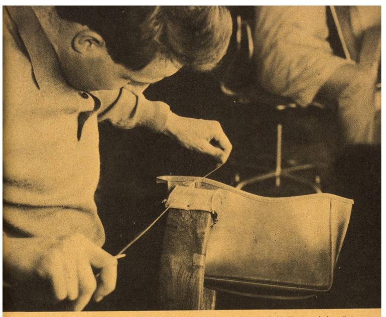
Nebst dem eigentlichen Handwerkzeug Nadel, Ahle und Halbmond benötigt der Sattler auch Nähmaschinen, Spalt-, Stanz-, Loch-, Schneide-, Verputz-maschinen und das Nähross (im Bild).
