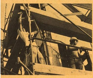
Das Haus nimmt langsam Formen an. Da alle Stellen für die weiteren Arbeiten auch von aussen zugänglich sein müssen, wird ein Baugerüst erstellt. Der Maurer kennt sich im Gerüstbau aus und weiss, wie er die (meistens im Baukastensystem erstellten) Teile zusammenmontieren muss.
