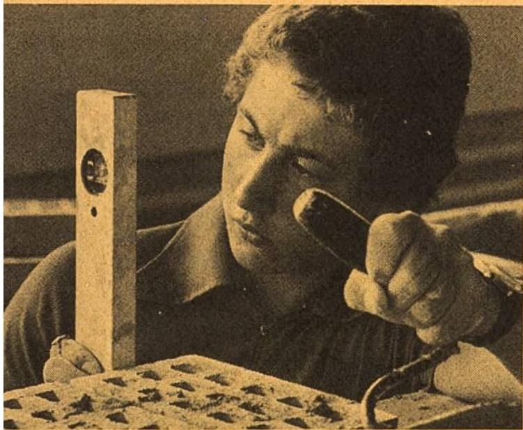
Mauern werden aus Steinen, am häufigsten aus Backsteinen, erstellt. Mit der Pflasterkelle wird der Mörtel aus dem Pflasterkasten auf den Stein geschöpft. Darauf wird ein neuer Stein gelegt und ausgerichtet. Neben der Wasserwaage werden hierzu auch andere Kontrollwerkzeuge wie zum Beispiel das Senklei, die Fluchtschnur und die Setzplatte verwendet.
