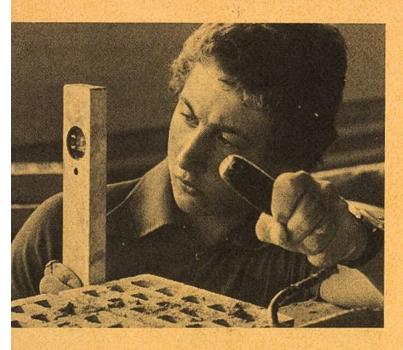
Mauern werden aus Steinen, am häufigsten aus Backsteinen, erstellt. Mit der Pflasterkelle wird der Mörtel aus dem Pflasterkasten auf den Stein geschöpft. Darauf wird ein neuer Stein gelegt und ausgerichtet. Neben der Wasserwaage werden hierzu auch andere Kontrollwerkzeuge wie zum Beispiel das Senkblei, die Fluchtschnur und die Setzplatte verwendet.
