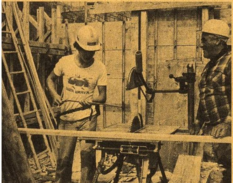
Häufig werden Schalungen für Betonkonstruktionen gefertigt. Für den Bau solcher Verschalungen verwendet der Maurer vorwiegend genormte Holzteile, die er hier für eine Wandschalung zusammenstellt. Im weiteren werden Schalungen für Stützmauern, Brückenkonstruktionen, Unterzüge, Massivdecken und Treppen verwendet.
