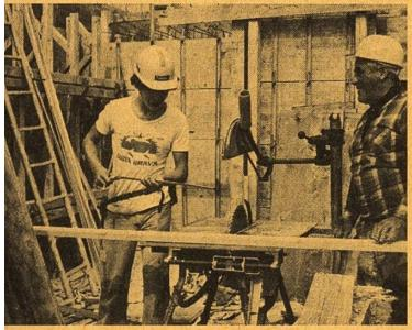
Häufig werden Schalungen für Betonkonstruktionen gefertigt. Für den Bau solcher Verschalungen verwendet der Maurer vorwiegend genormte Holzteile, die er hier für eine Wandschalung zusammenstellt. Im weiteren werden Schalungen für Stützmauern, Brückenkonstruktionen, Unterzüge, Massivdecken und Treppen verwendet.
