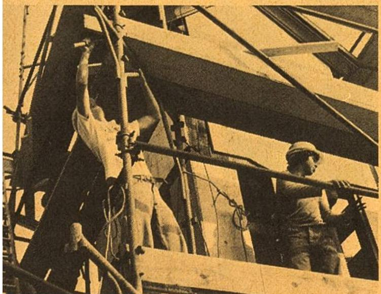
Das Haus nimmt langsam Formen an. Da alle Stellen für die weiteren Arbeiten auch von aussen zugänglich sein müssen, wird ein Baugerüst erstellt. Der Maurer kennt sich im Gerüstbau aus und weiss, wie er die (meistens im Baukastensystem erstellten) Teile zusammenmontieren muss.
