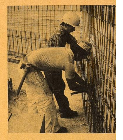
Die Stahlarmierung und die Schalung sind fertig. Nun kann der Maurer mit dem Einbringen des Betons beginnen. Für diese Arbeit steht ihm in der Regel ein Baukran oder eine Betonpumpe zur Verfügung.
