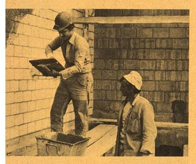
Wenn die Mauer fertig erstellt ist, kann sie verputzt werden. Wieder mit der Pflasterkelle wird der Mörtel, diesmal vom sogenannten Talosche, genommen und an die Mauer aufgezogen.
