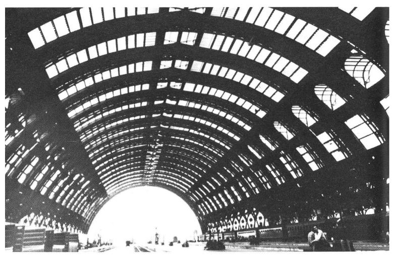
Bewegungen im alten Bauwerk des Mailänder Bahnhofs haben einen Teil des Glasdachs zerstört und dessen Gefährlichkeit zutage treten lassen. Das zweimal leichtere «Acrylglas» (Vedril® der Firma Montedison), mit dem man die Halle nun «verglaste», würde im Fall eines Falles sanft zu Boden gleiten.
