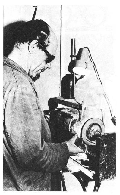
Mit dieser Diamantscheibenfräse schneidet der Glasbläser grössere Stücke zu. Dünnere Röhren können mit dem Ritzmesser bearbeitet werden.
